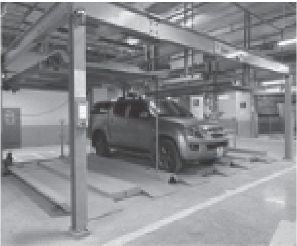
Hình 2. Hệ thống nhà đỗ xe 2 tầng tại Chung cư The Nine-Phạm Văn Đồng
