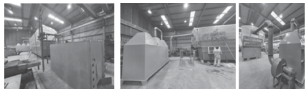
Hình 8. Hình ảnh kết quả chế tạo và lắp đặt toàn bộ hệ thống thiết bị [1]
