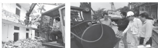
a) b) Hình 2. Thực nghiệm kết quả nghiên cứu KHCN cấp bộ GTVT: a) Bộ công tác cắt bê tông cốt thép; b) Bộ công tác nghiền đá
