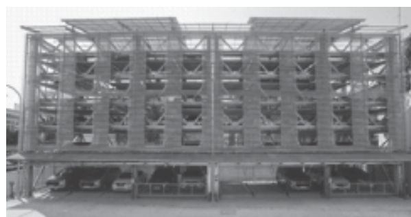
Hình 3. Nhà đỗ xe 6 tầng tại 255 Phan Châu Trinh - Đà Nẵng
