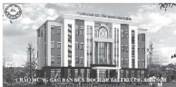
Hình 1. Hình ảnh Dự án Nhà điều hành A2 - Trường ĐHCNQ - QUI đã được khai thác sử dụng 01.2023
