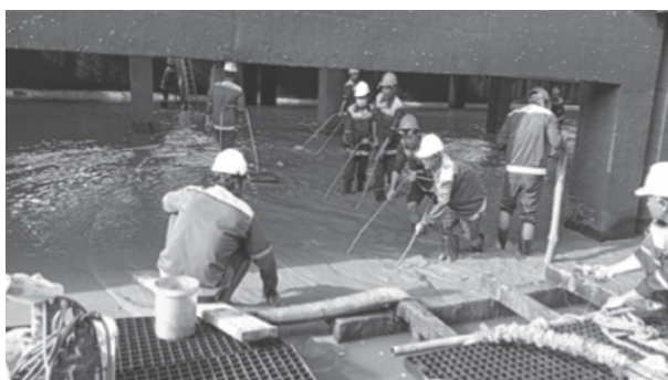
Hình 5. Dọn bùn đáy bể làm mát theo phương thức thủ công
