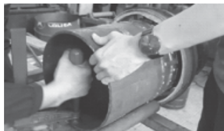
Hình 3. Lắp bánh răng dẫn vào ống và gá lên
